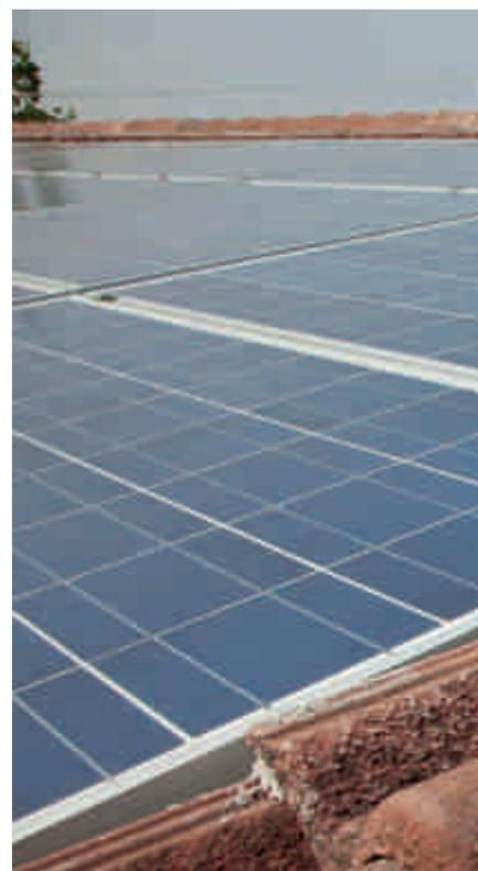
**supporto ai pannelli che poi verranno posizionati sopra allo strato di copertura (non in sostituzione).** I punti d'ancoraggio andranno a forare una piccola parte della copertura per potersi fissare ad uno strato portante. Questa soluzione si adatta ai casi in cui il sistema fotovoltaico venga installato dopo la copertura, evitando di intervenire in maniera più consistente dovendo rimuovere le tegole. Anche in questo caso, se il tetto è ventilato, le prestazioni dei pannelli saranno migliori.
