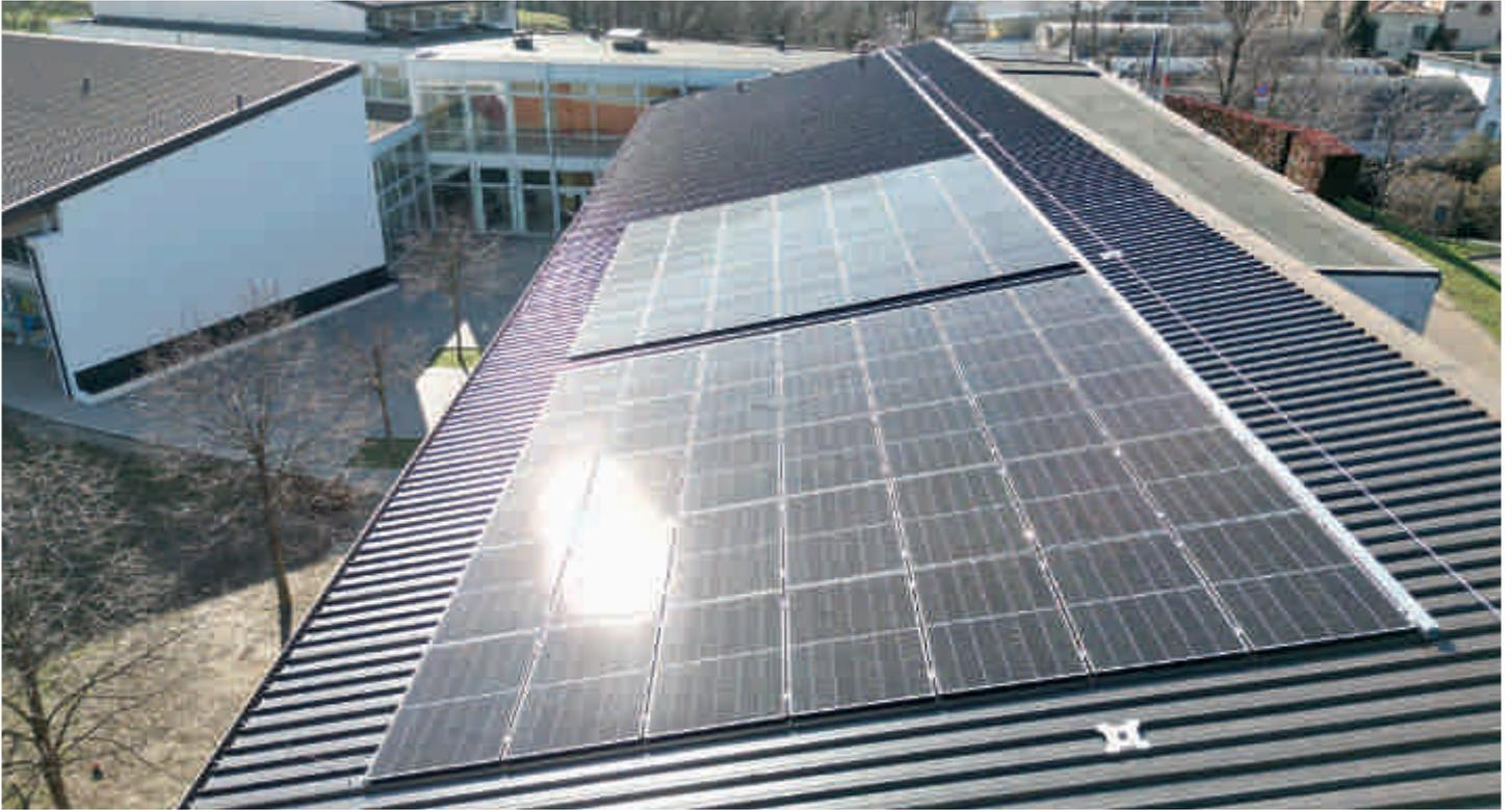
**Nella foto in alto, l'impianto fotovoltaico e la linea vita realizzati dalla Sole sul tetto della scuola**
