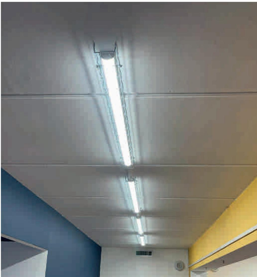
**Particolare delle griglie installate a protezione delle plafoniere negli ambienti di allenamento**
